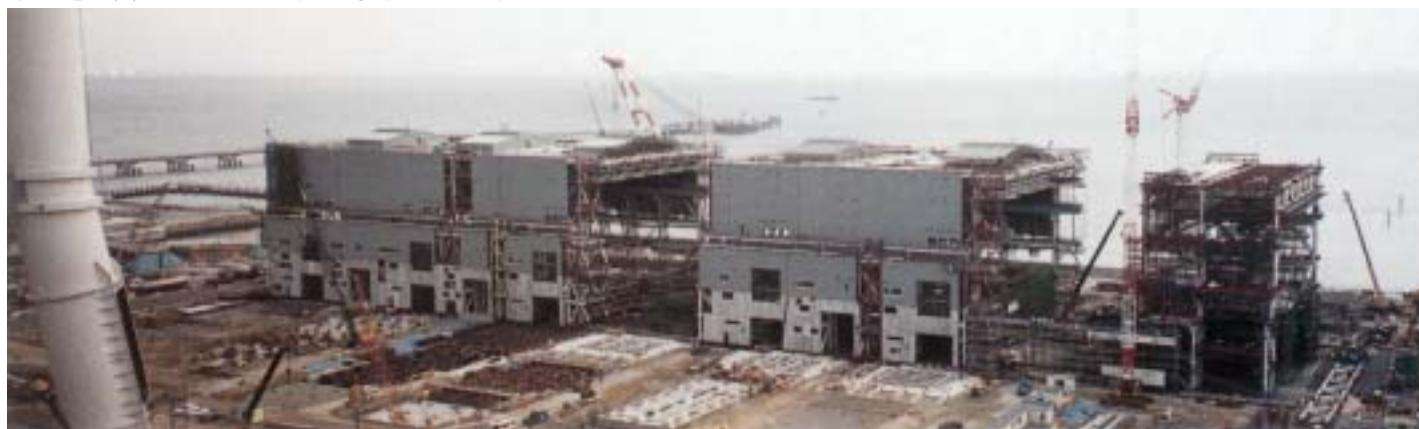
中部電力(株)川越火力4号館工事(6年12月)
