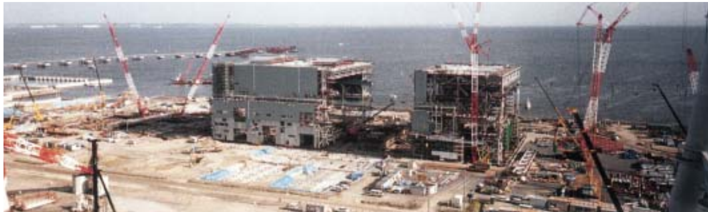
中部電力(株)川越火力4号本館工事(6年9月)
