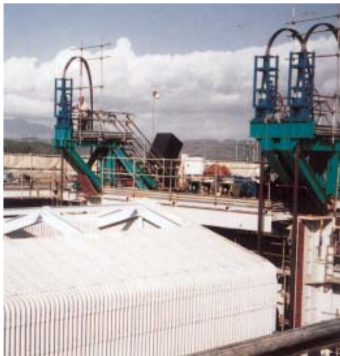
リフトアップ中のトップガーダー屋根部
