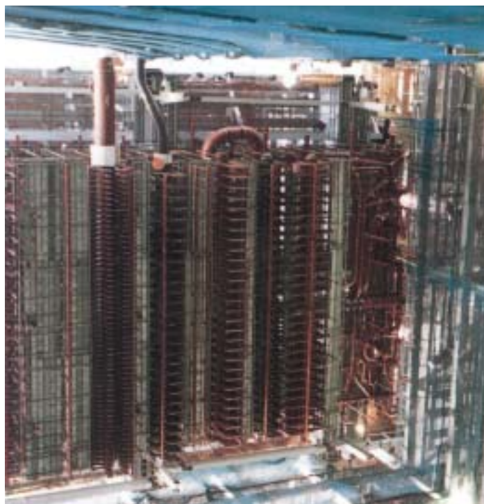
トップガーダー下に取付けたボイラー部材
