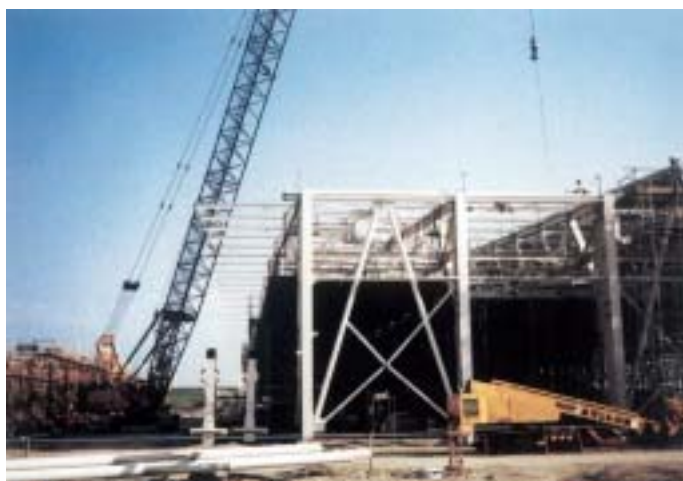
構台上で組み立て中の屋根
