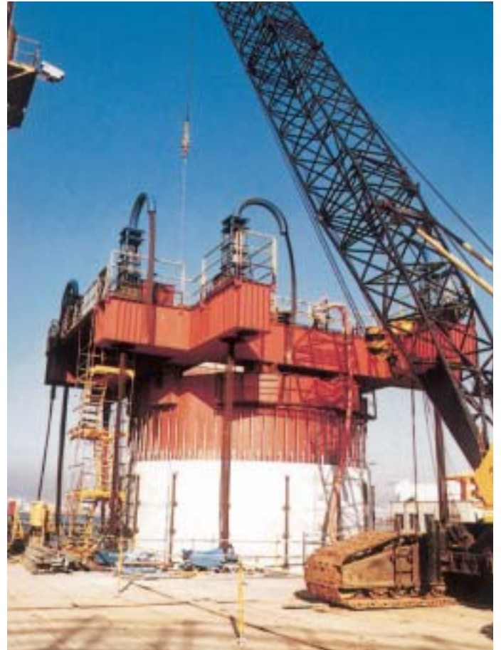
S58～S62 横浜ベイブリッジケーソン
