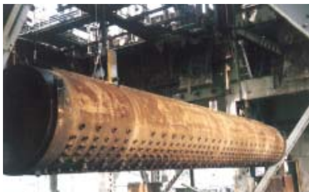
重量140tの蒸気ドラムの降下解体
