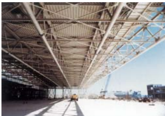
構台前面に引き出された屋根
